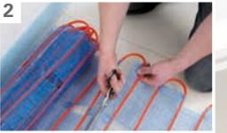
Die Heizmatte umklappen und befestigen. Dann gegenläufig zurückrollen. Der Abstand zwischen den Bahnen sollte 8 cm betragen – bitte nachmessen! Die Bahnen, wenn nötig, mit Fixierdübeln befestigen.
