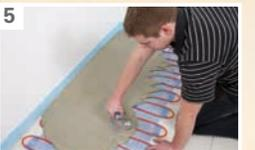
Auf die trockene Spachtelschicht für Fußbodenheizungen geeigneten Fliesenkleber auftragen und den Oberbelag darauf verlegen – fertig!
