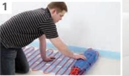
Am Raumende das Gewebematerial, auf dem die Heizleitungen befestigt sind, passend aufschneiden.
