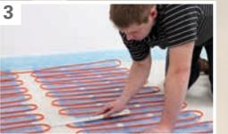
Nun die Heizleitungen mit dem vorhandenen Zentralheizungssystem verbinden und eine Dichtigkeitsprüfung durchführen.
